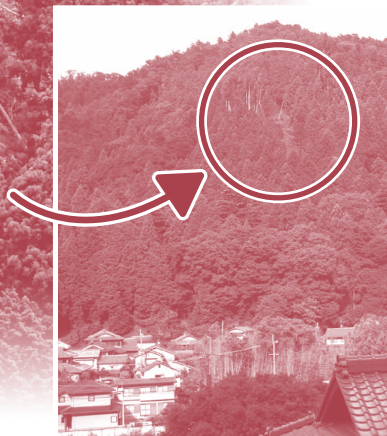
左京区八瀬秋元町の山腹が崩れ下の住宅に土砂が
