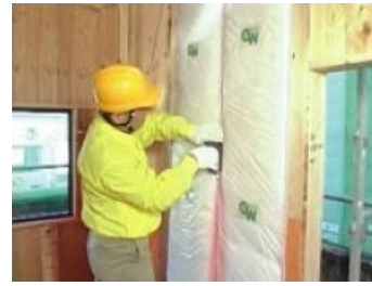
外壁への断熱材設置
