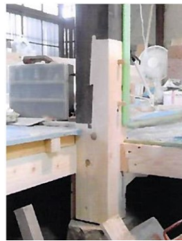
柱等の劣化修繕
