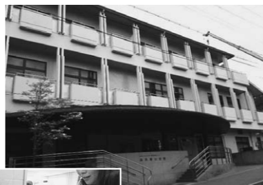
「ふれあいの里保養研修センター」外観
