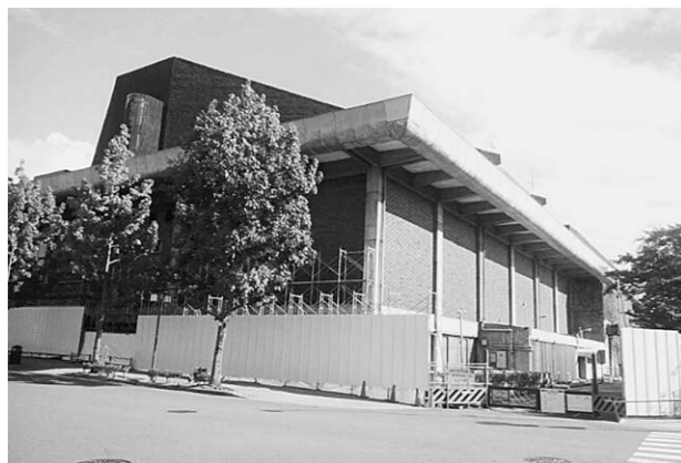
解体工事が始まっている京都会館（9月頃）
