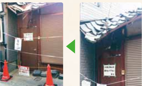
●東堀町「梅雨の井」付近 空き家の屋根瓦 対応前と対応後
