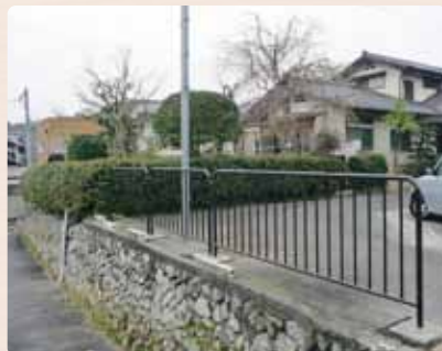
●私道に設置された柵
