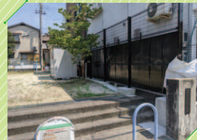
梅津尻溝公園の危険ブロック塀を改修
