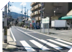
▲三条通りの舗装(嵐山区)
