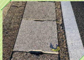
宇多野で側溝改修
