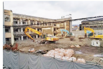
元植柳小学校跡地。ホテル建設に向けて進む解体工事
