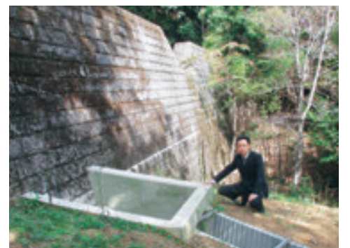
えん堤の脇に水路が完成写真右側に住宅がある
