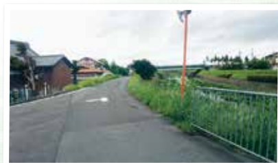
▲ 西高瀬川の測道で車を避けるため、80代の男性が川に落ちる事故が。現地を見てもらい、転落防止柵の設置を約束してもらいました。
