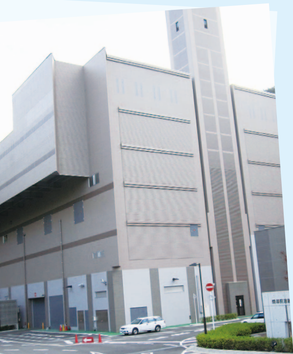
▲今後、解体される焼却灰溶融施設* *ごみを燃やした灰を高温でとかし、固めて容量を2分の1にする施設
