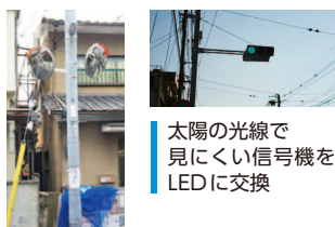
見通しの悪い細街路に カーブミラーを設置
