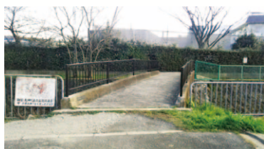
欄干のなかった危険な橋に 欄干を設置
