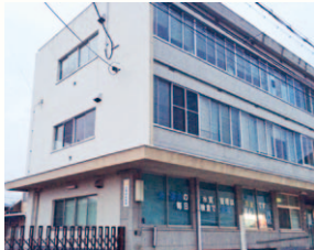
水道局旧伏見営業所 (深草石橋町)
