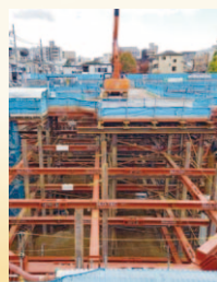
ホテル建設中の 元植柳小学校跡地
