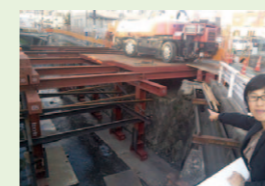
安祥寺川橋の 道路拡幅が実現
