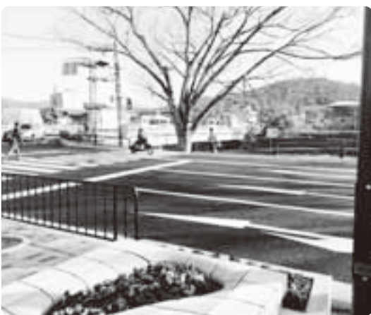
拡幅工事が完成した御園橋西詰め(2013年3月)
