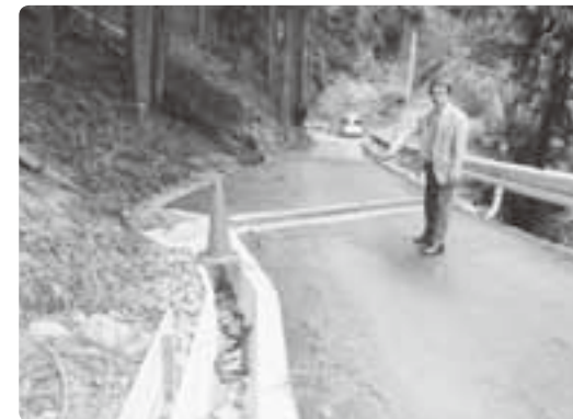
補修された府道黒田—貴船線
