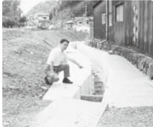
改修された農業用水路
