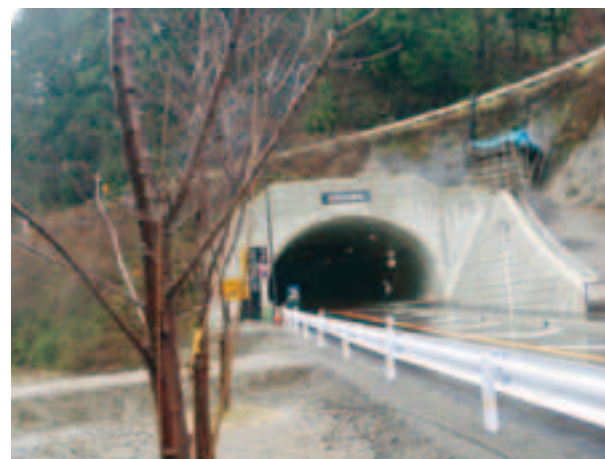
完成した京北トンネル(2013年12月)
