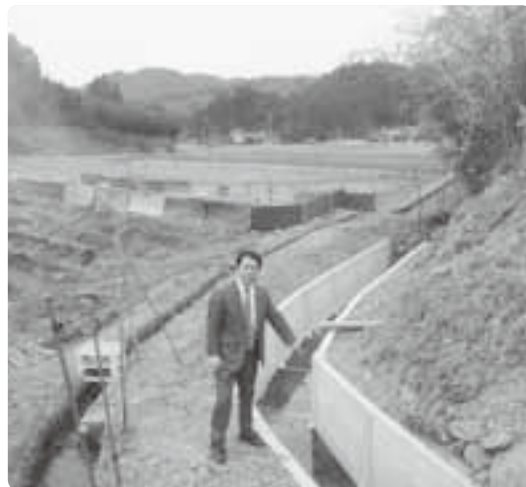
改修された農業用水路
