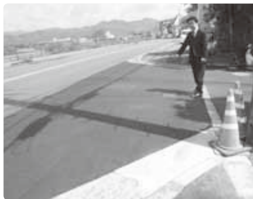
梅津森原堤防、上下水道管が通ったところ
