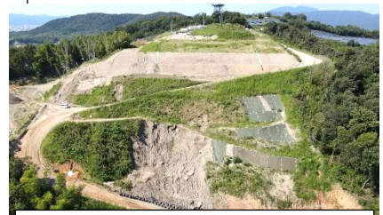
伏見区大岩山の産廃土砂違法埋め立て現場。大雨で崩落し、市に対策を求めた（2021年8月撮影）
