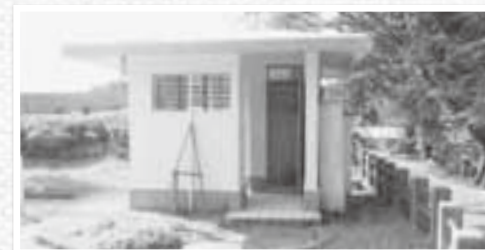
岩倉の公園のトイレの電気が切れていたものを交換
