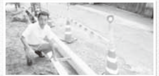
修学院で側溝が崩れ、道路が陥没していた箇所を改修
