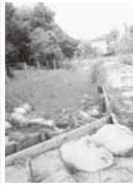
2013年3月に仮設水路が完成した
