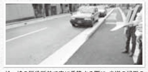
松ヶ崎の区役所前で車に乗降する際に、歩道の縁石の段差が危険だった箇所を平らに改修
