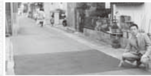
上高野で道路を横断する排水路を改修して暗渠に
