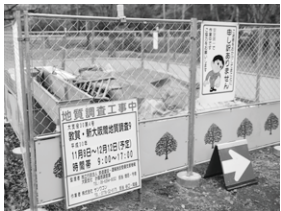
水道管を破損した宝ヶ池公園の調査地(2018年11月23日撮影)
