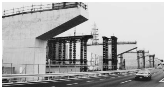
1本1億円以上の橋脚がならぶ油小路
